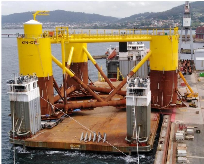
Figura 20: Construcción de una plataforma flotante en el Astillero de Fene, Ferrol<sup>7</sup>.
