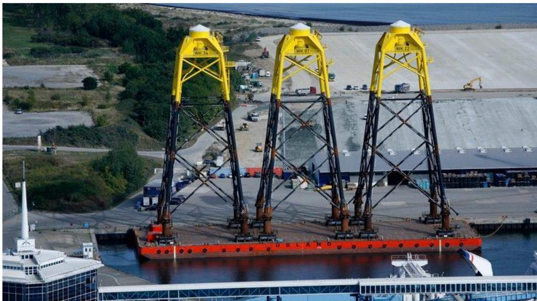
Figura 3: Cimentación fija tipo Jacket para el parque eólico marino de Wikingen, Alemania (Fuente: Iberdrola).
