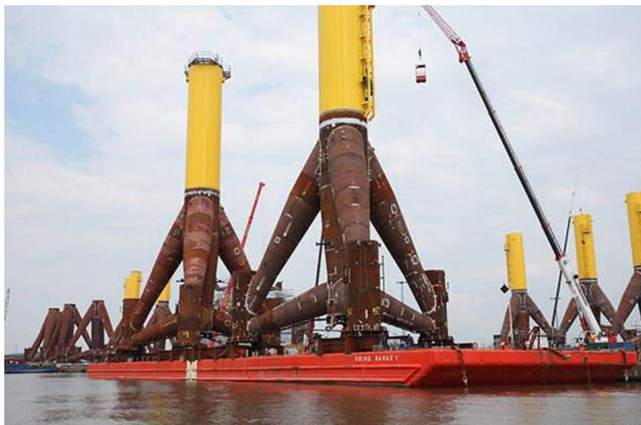
Figura 1: Cimentación fija trípode (Fuente: Power Technologies).
