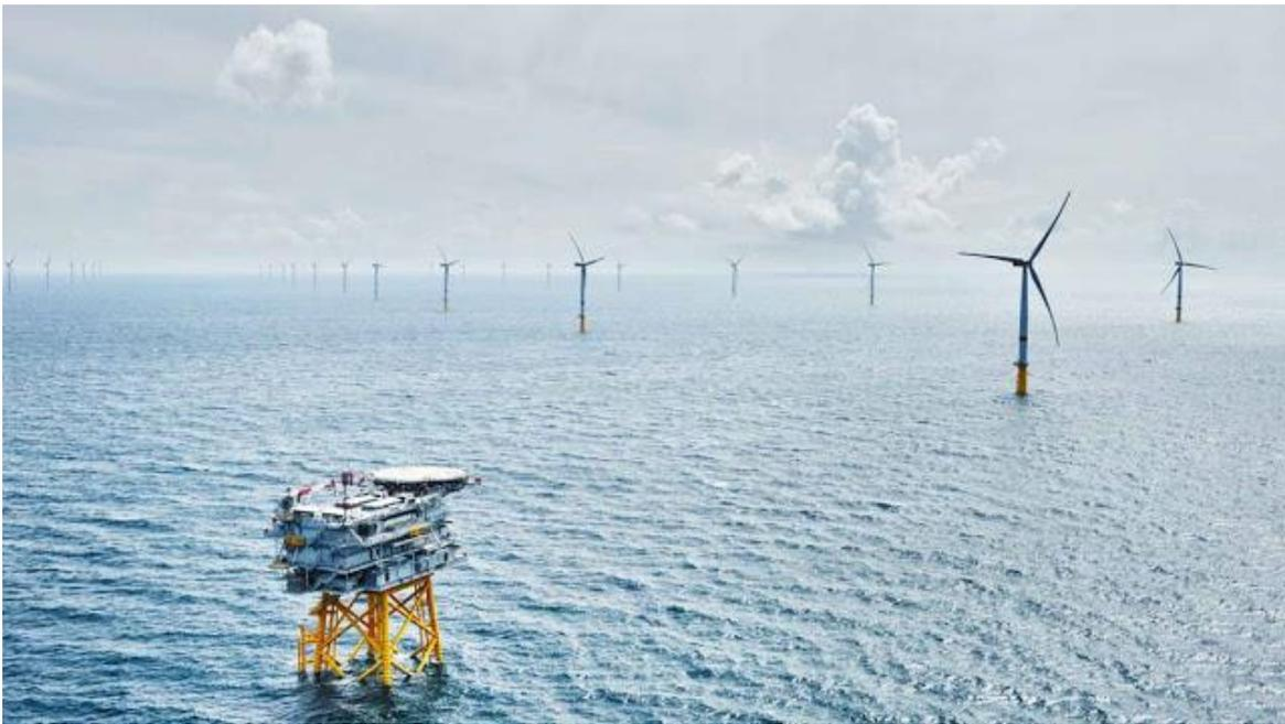
Figura 12: Disposición de un parque eólico marino, en la cual se aprecia la subestación en primer plano y la disposición en filas de los aerogeneradores.<sup>2</sup>
