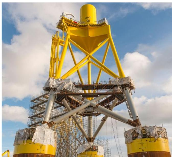
Figura 4: Cimentación fija con suction buckets (Fuente: Smulders).
